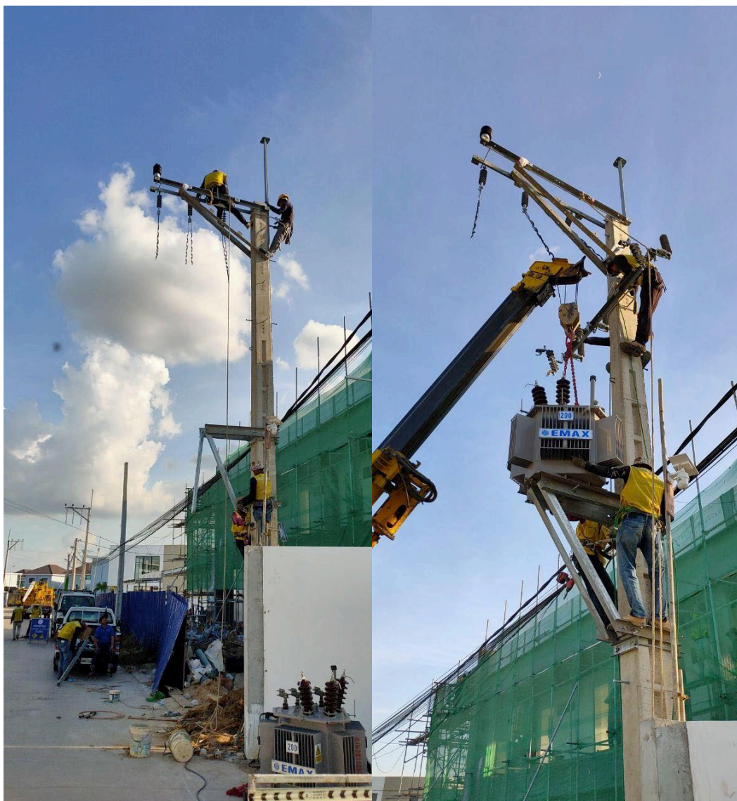
Oplevering van de elektriciteitsaansluiting door het staatsbedrijf EDC (Électricité Du Cambodge) in volle gang. Voor het medisch centrum is een afzonderlijke transformator nodig.
