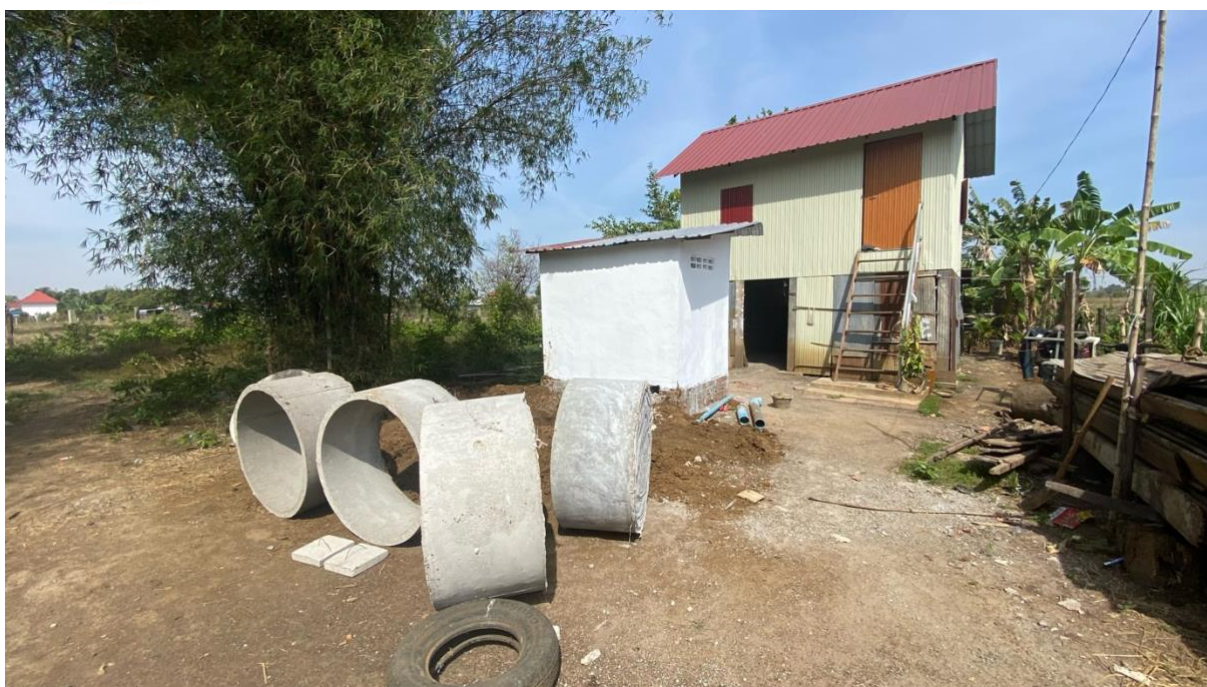
Nieuw huis in de provincie Kampong Cham met daarvoor in aanbouw een sanitaire voorziening
