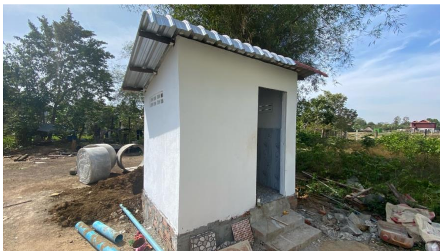
Sanitaire voorziening met toilet in laatste fase van de bouw
