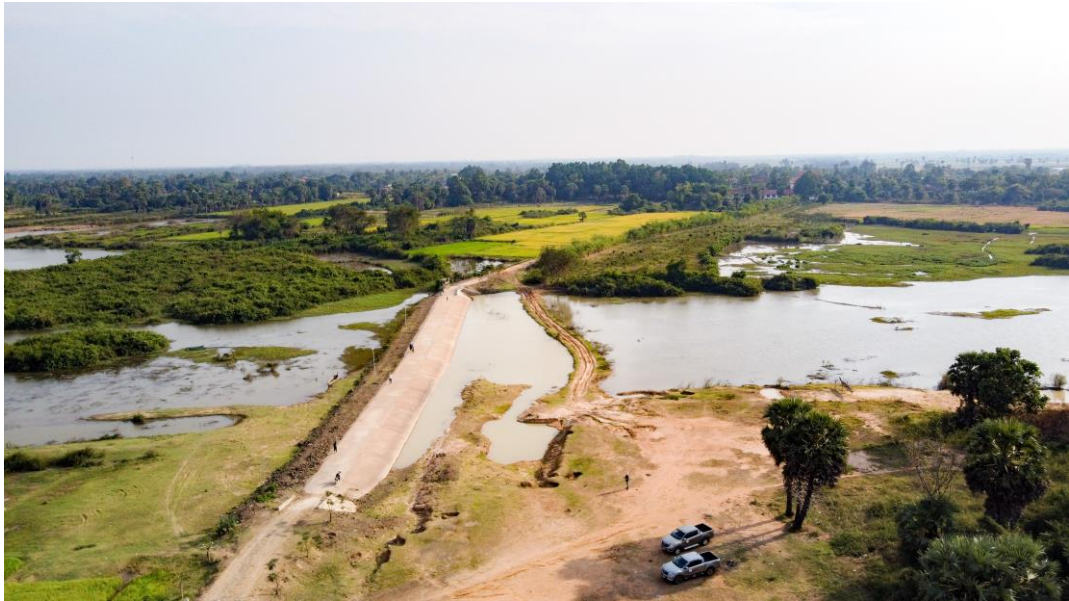
Met de grote Kdak-dam in 2019 gebouwd kunnen de boeren in de omgeving het water beheersen, vasthouden en irrigeren tijdens natte en droge periode's van het jaar
