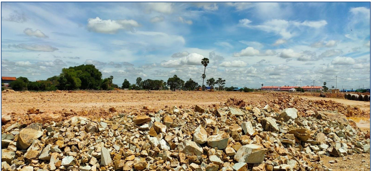
Omdat de grond erg laag ligt (rijstveld) wordt de kavel opgehoogd.
