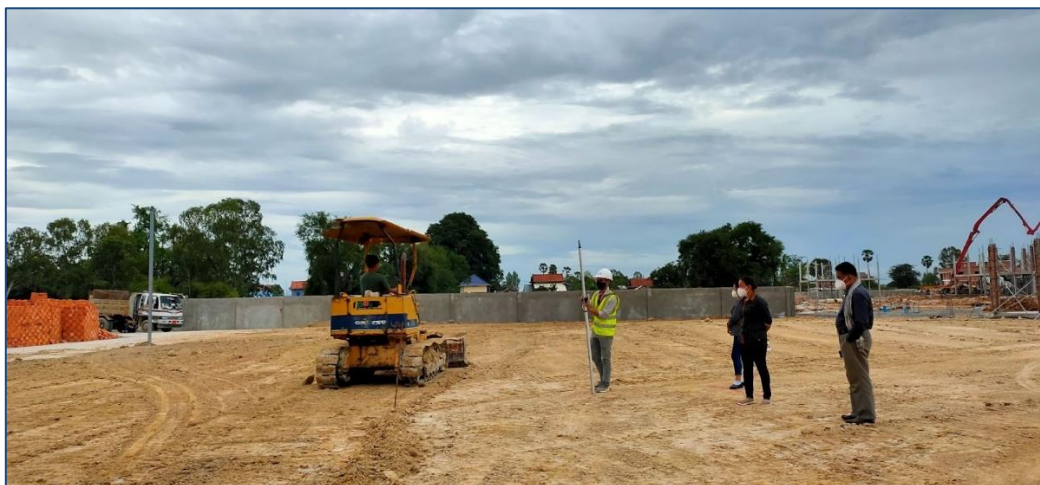
Het bouwrijp maken van de kavel.
