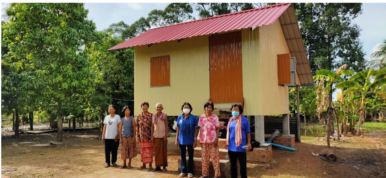
Een klein huis voor een gehandicapte moeder en haar dochter. Omdat het water hier nogal hoog kan staan in het regenseizoen zijn de pilaren opgehoogd.
