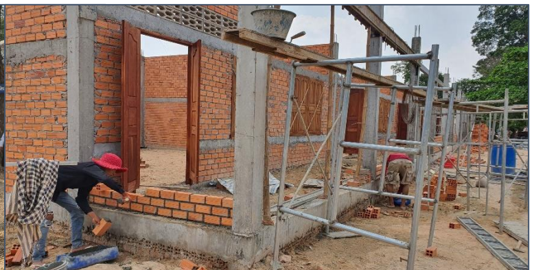
De bouw van de school in Prey Veng in volle gang...
