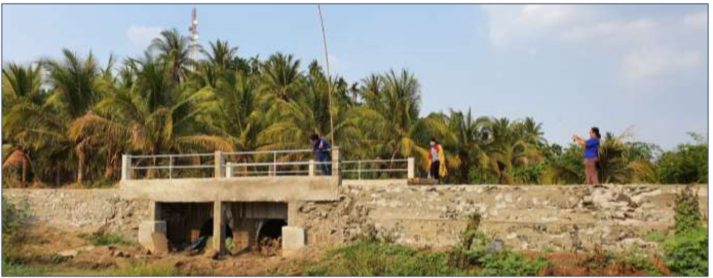
De nieuwe brug die Spien dit jaar heeft gebouwd in Chamcar Leu, Kampong Cham
