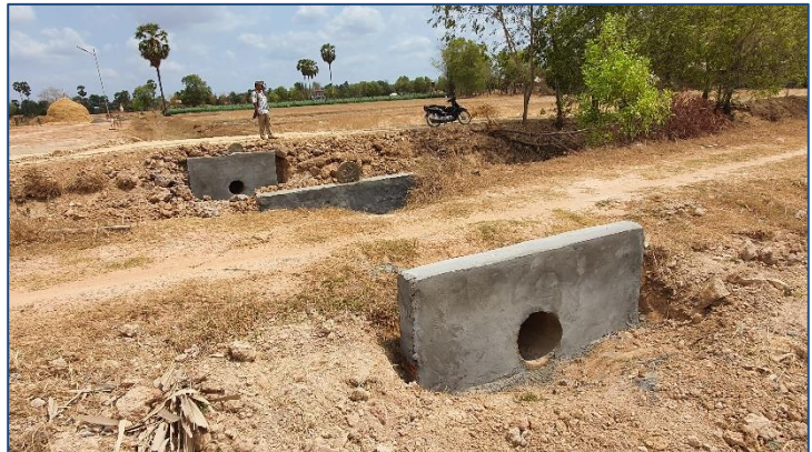
Duiker onder een weg, een klein project, maar heel belangrijk. In de regentijd zal deze zorgen dat de weg begaanbaar blijft.
