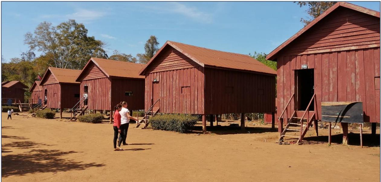
De basisschool, elk gebouw is een klaslokaal
