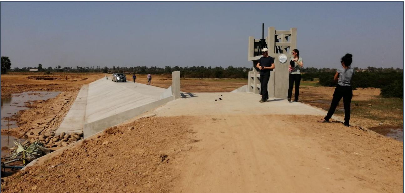
Kdak Dam, geopend in de eerste week van dit werkbezoek.
