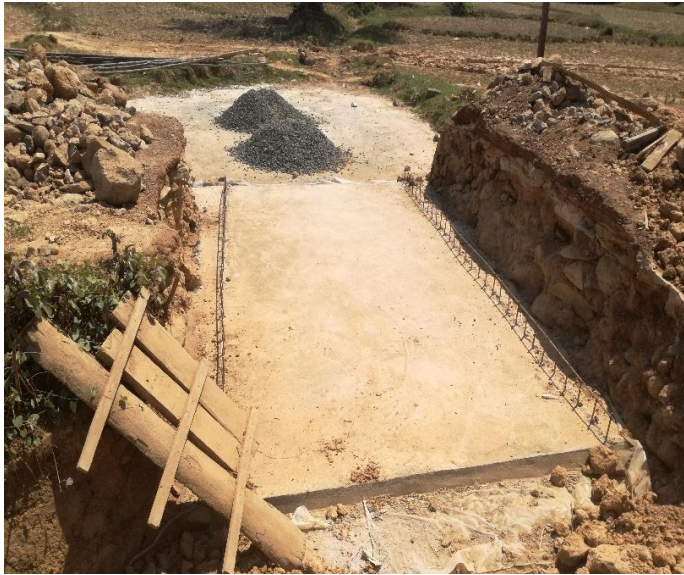
Aanleg van een brug
