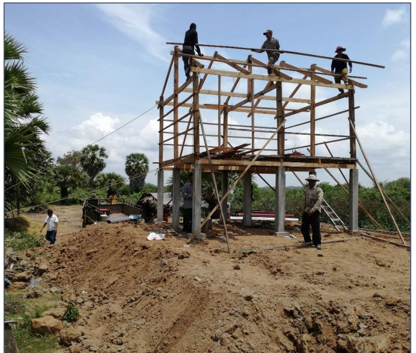
Het nieuwe huis in aanbouw. Op de achtergrond (naast de vrachtwagen) het oude 'huis'.
