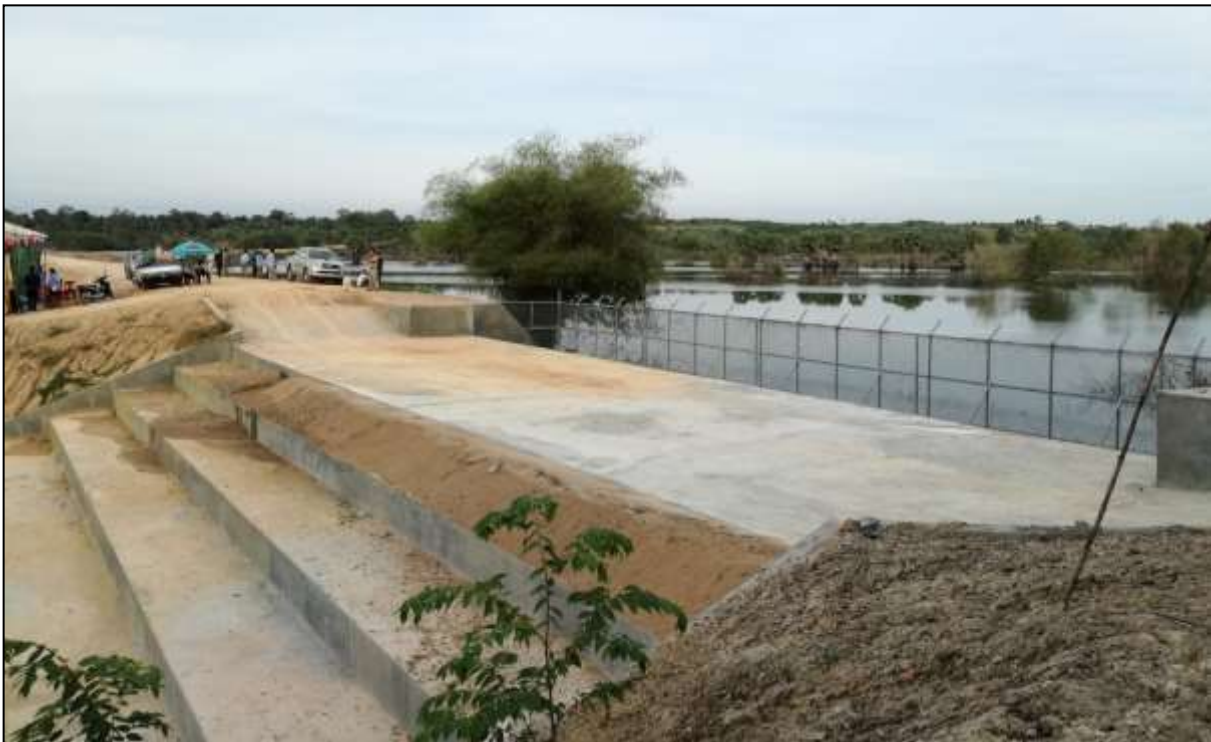
Op deze plek kan het water wegvloeiën als het reservoir te vol wordt.
