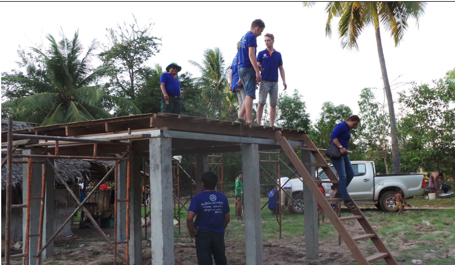
Aan het eind van dag 1 staat de fundering. Het eindresultaat laten we een andere keer zien.
