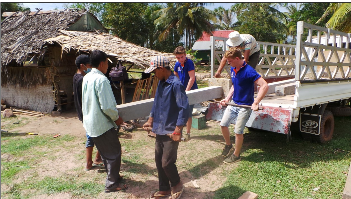
Jens en Stefan helpen met het uitladen van de betonnen palen.
