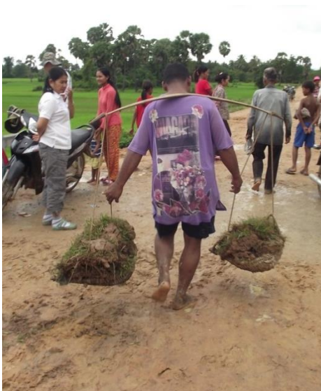
Als bescherming van de dijken worden graszoden of struiken door de boeren aangebracht
