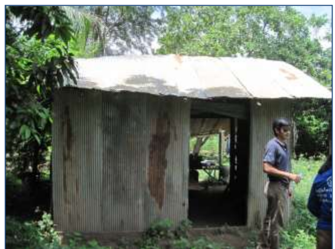
Ook hier woont een gezin met kinderen. Het gezin had geen andere keus dan in dit golfplaten huis te wonen. Golfplaten absorberen veel warmte en het is dan ook bloedheet binnen.
