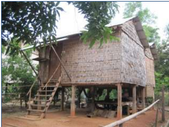
Een nieuw Spie-en huis. Het huis is op palen gebouwd en heeft dus geen last van de overstromingen van de Mekong Rivier.
