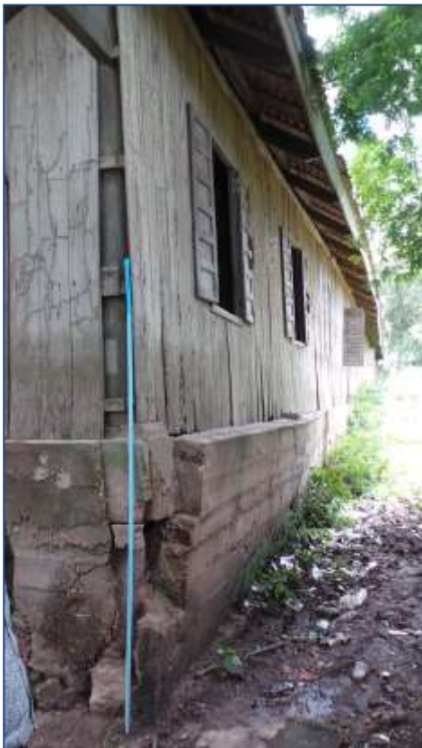
De stenen muur is aan het verzakken. De donkere rand op het hout geeft aan hoe hoog het water hier heeft gestaan!
