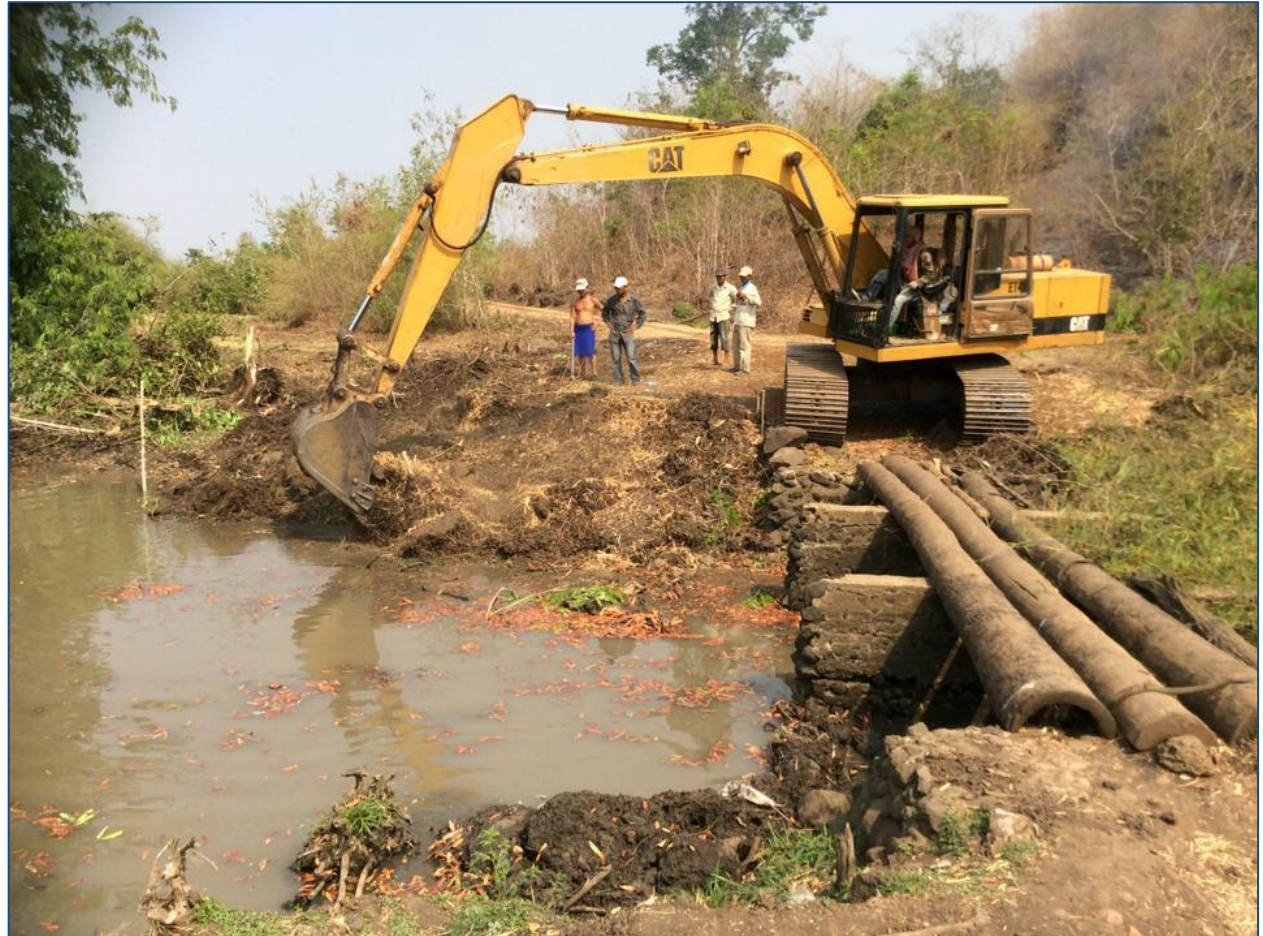
Op deze plaats wordt een nieuwe brug gebouwd. Rechts op de voorgrond de oude brug.
