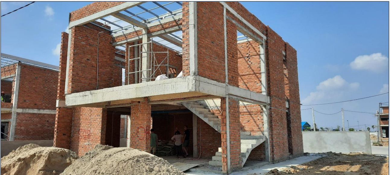
Het nieuwe Spien kantoor in aanbouw
