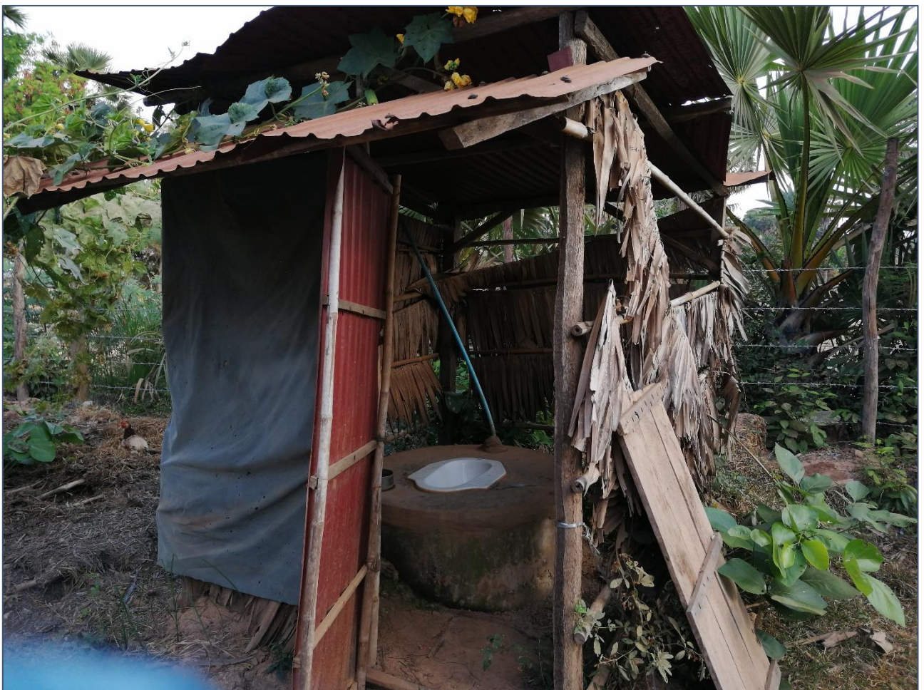
Toiletgebouw achter een huis
