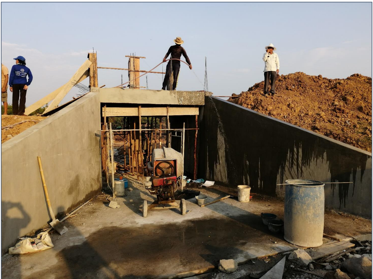
Even kijken bij Kdak Dam. De sluis is al bijna klaar....
