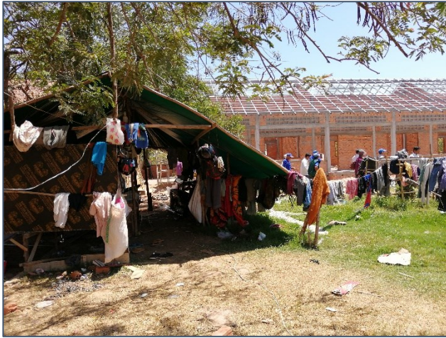
De arbeiders verblijven in deze tent tijdens de bouw. Ze slapen hier. Ook wordt hier gekookt en wordt de was gedaan.
