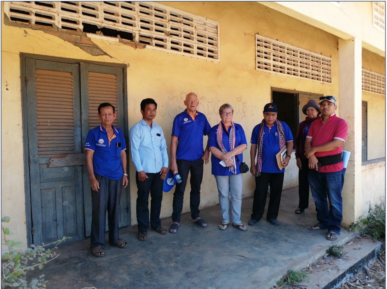
We hebben een uitnodiging gekregen om te kijken bij een school waarvan de fundering is verzakt. In het midden van de school zit een soort knik in de muur. Het is te gevaarlijk om hier nog les te geven. We krijgen het verzoek om hier een nieuwe school te bouwen. Leerlingen hebben nu les in bijgebouwen in de buurt, maar dit is een onhoudbare situatie. Ook hier overvolle klassen. We gaan het bespreken.
