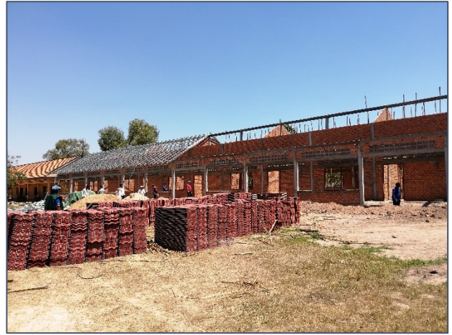
De dakpannen staan al klaar om gelegd te worden. Over een week of 6 zal de school naar verwachting gereed zijn. Werken in 37 graden hitte.....
