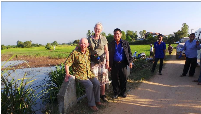
Deze brug is gemaakt in 1996. Jan van Heteren is hier destijds ook geweest. Nu is hij terug met zijn vrouw. Deze brug was één van de eerste projecten in de provincie Takeo.
