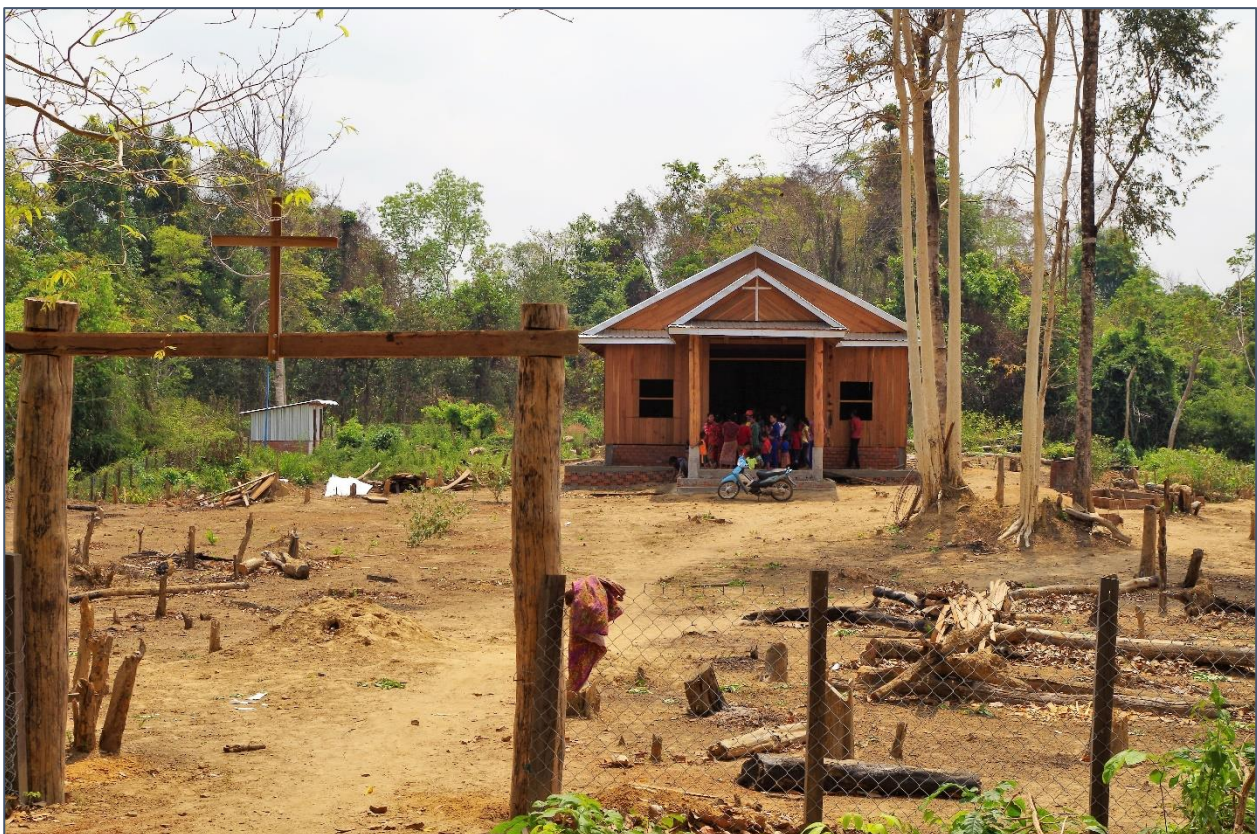
Zo ziet het kerkterrein er uit als je vanuit het dorp komt. Links achterin staat het toiletgebouw.
