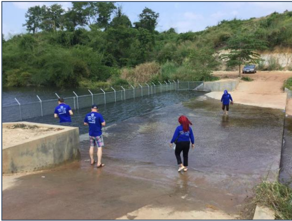
Het reservoir bij Ou Som zit vol. Er is een overloop gemaakt om de dijken te beschermen.
