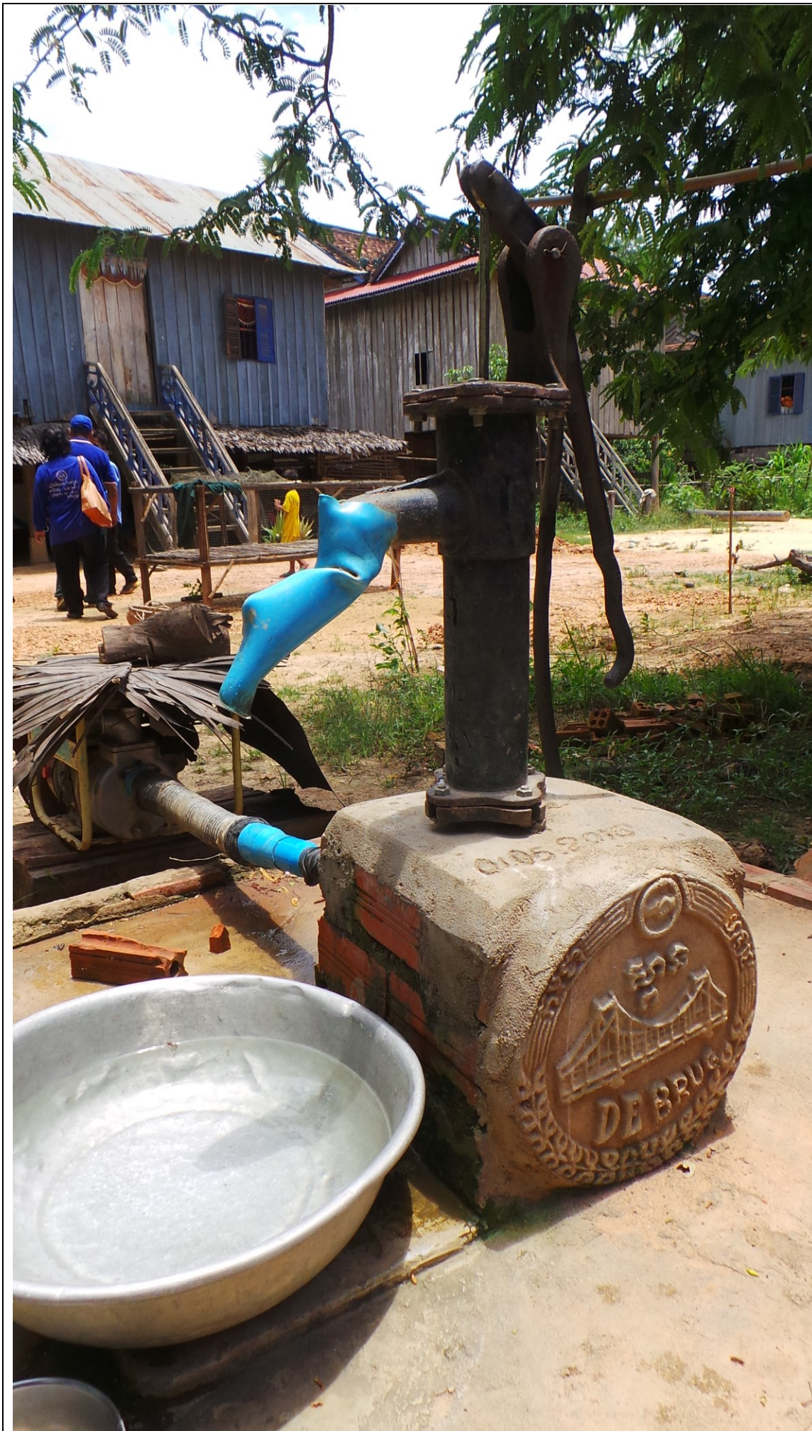
Een Spie-en pomp die van 40 meter diep water uit de grond pomt.
