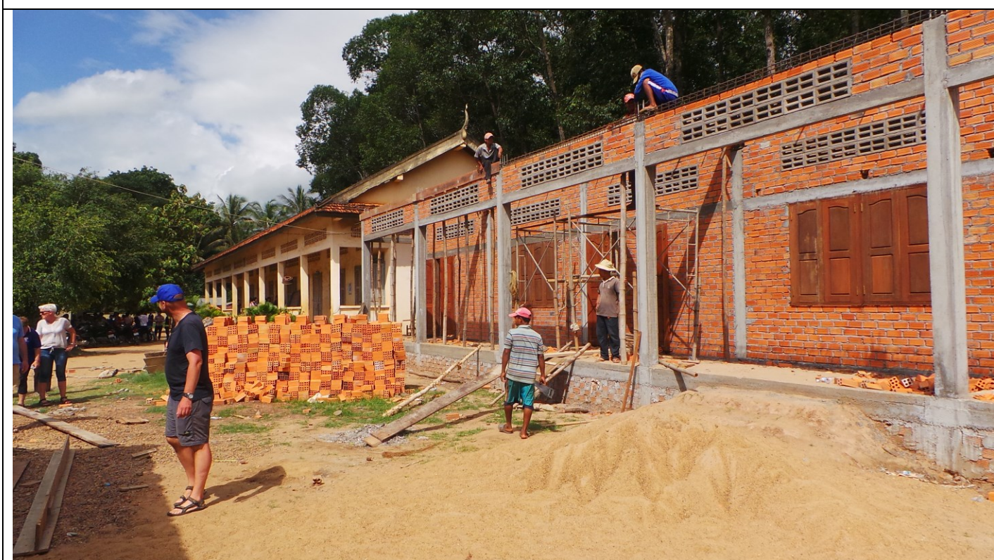
De school in Pong Rokeut in aanbouw. Over zes weken is hij klaar.
