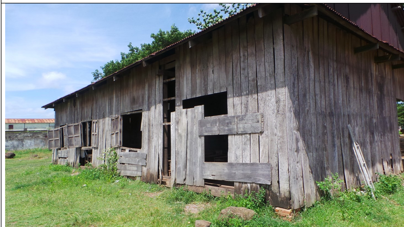
Een oude school die nog wordt gebruikt en aan vervanging toe is.
