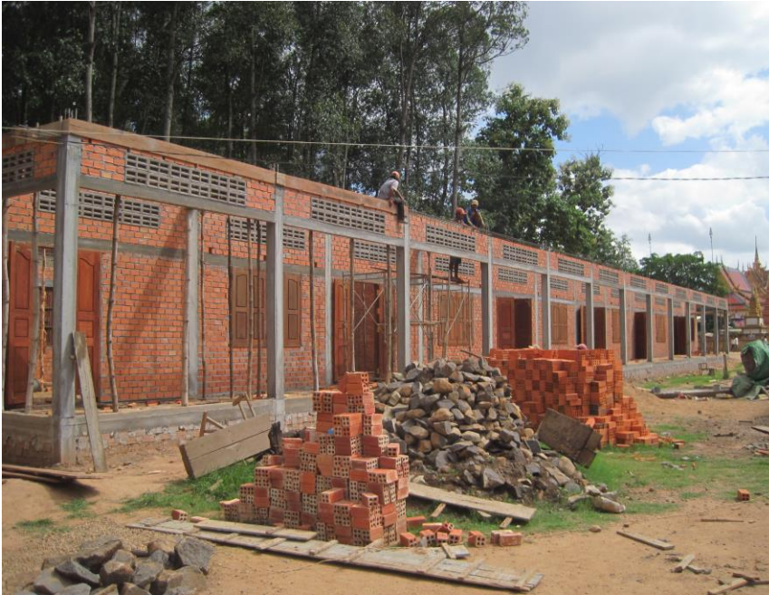
De school in Pong Rokeut in aanbouw
