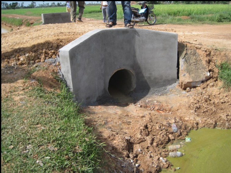
Een duiker onder de weg door is belangrijk om de weg te beschermen tegen overstrooming.
